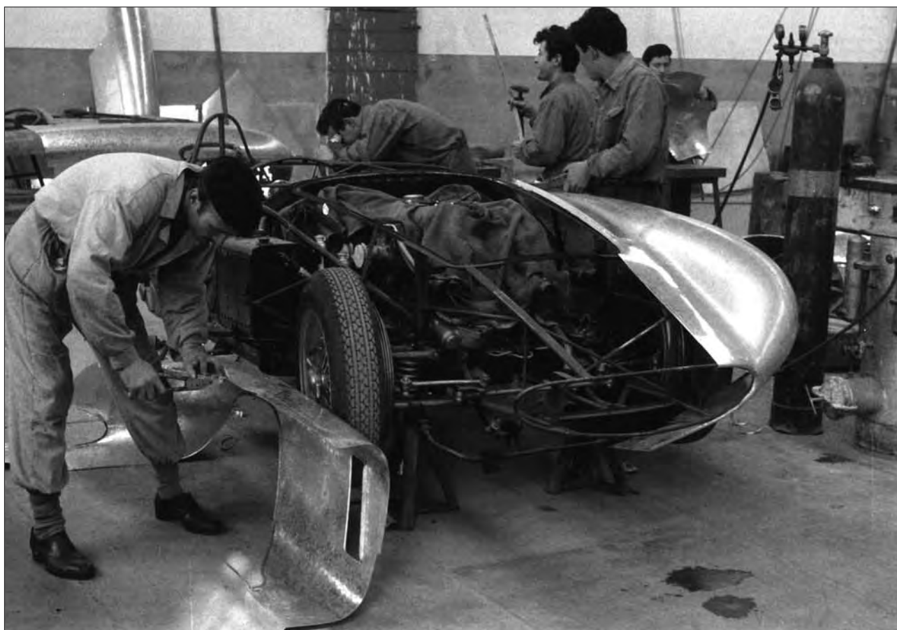
Il lavoro alla Carozzeria Scaglietti negli anni Cinquanta. Il montaggio delle parti di carrozzeria, battute e sagomate a mano, sulla struttura tubolare fissata al telaio. Le parti venivano poi saldate, come dimostra la bombola sulla destra.
